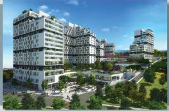
İSTANBUL İNANLAR İNŞAAT / TERRACE MIX 62 PCS. LECTUS 115
