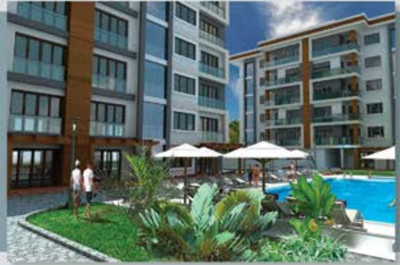
İSTANBUL BAYRAMOĞLU İNŞAAT / TUZLA YAYLA PARK EVLERİ 130 PCS. COMBI BOILER / 1.550 MTUL PANEL RADIATORS
